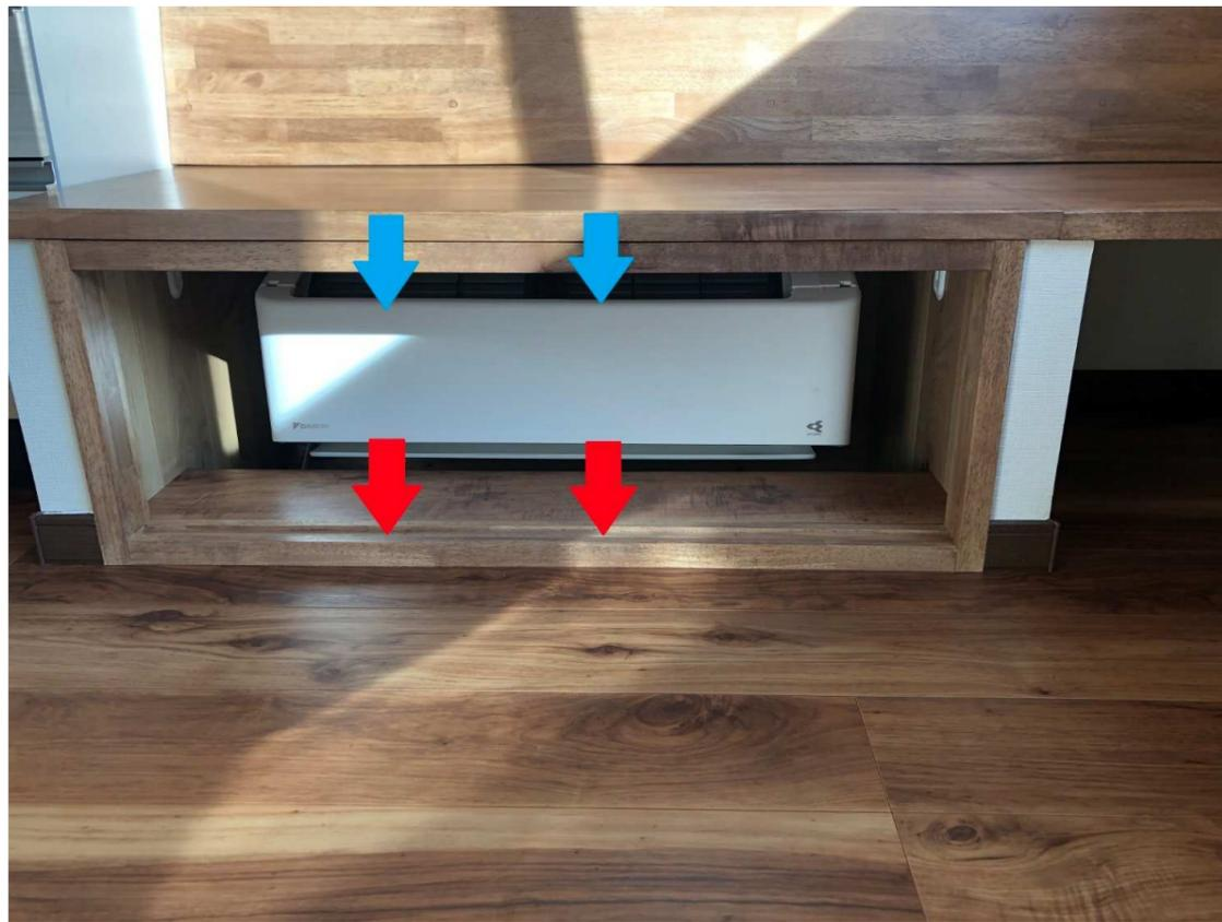
エアコンは、ダイキンのスゴ暖。室内機本体は、カウンターの中で半分床下に埋込ます。床面付近の空気を吸い込んで、床下の空間へ吹き出します。
