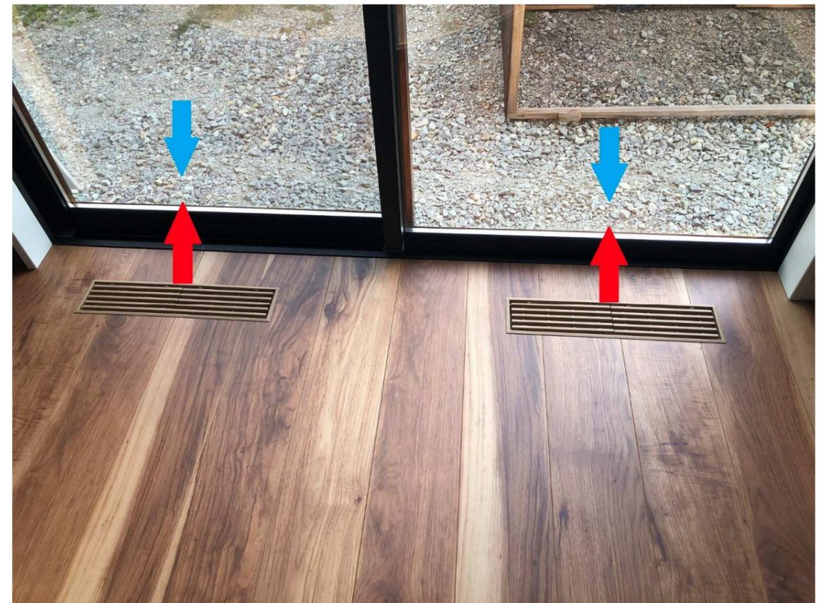
①床ガリ: 取付位置は、窓の下付近。その理由は、冬期間はガラス面が冷やされ冷気となって降下します、不快な冷気を防ぐために窓下が最適な位置になります。
